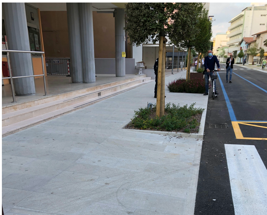
Fig. esempio di pavimentazione già realizzata nel primo tratto
