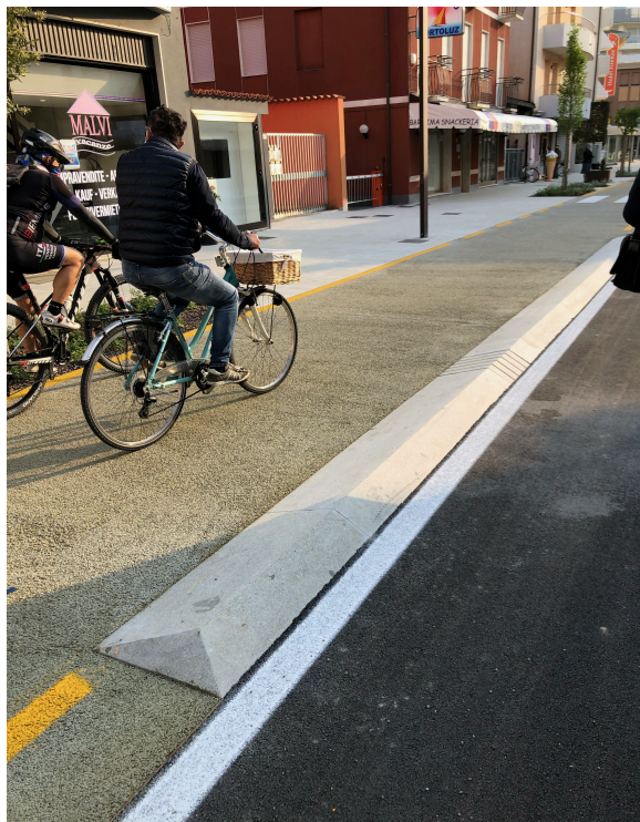
Fig. cordolo custom già realizzato nel primo tratto
