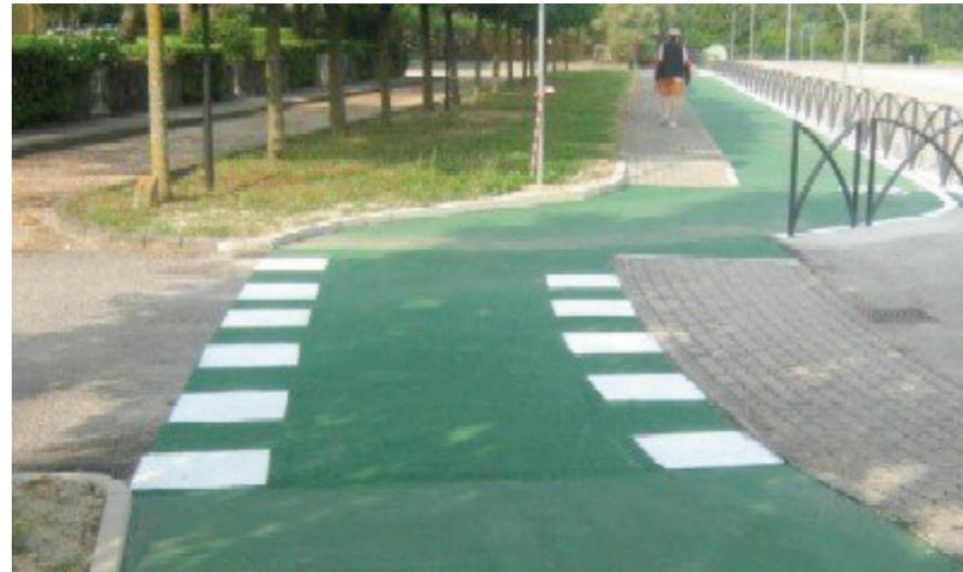
fig. 111: Attraversamento ciclabile con superficie in asfalto colorato in verde a Duna Verde
