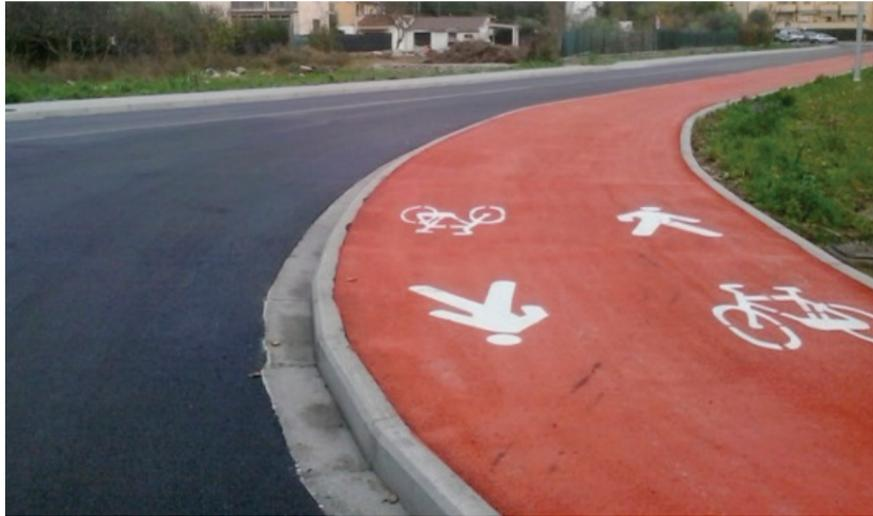
fig. 136: Percorso ciclopedonale a doppio senso ciclabile su marciapiede rialzato (larghezza = 2,50 m + incremento adeguato, di norma tot. min 3 m)
