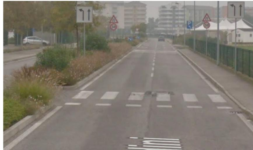
fig. 105: Attraversamento ciclabile con superficie in asfalto in via delle Rondini a Lido Alta-nea
