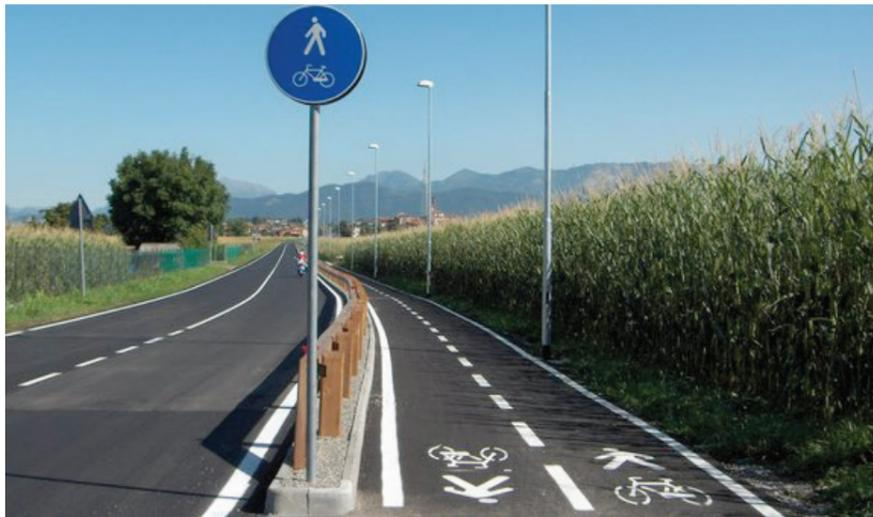
fig. 138: Percorso ciclopedonale a doppio senso ciclabile su marciapiede a raso con cordolo (larghezza = 2,50 m + incremento adeguato, di norma tot. min 3 m)
