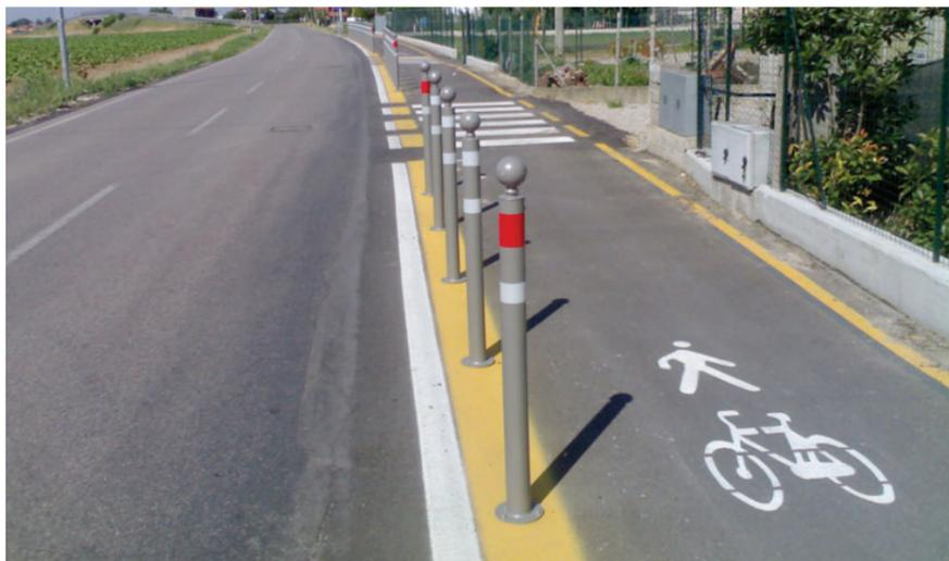
fig. 137: Percorso ciclopedonale a doppio senso ciclabile su marciapiede a raso con paletti dissuasori (larghezza = 2,50 m + incremento adeguato, di norma tot. min 3 m)
