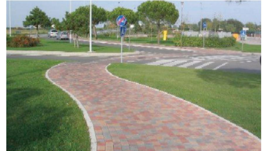
fig. 103: Percorso ciclabile con superficie in mattonelle in cemento a Porto S. Margherita
